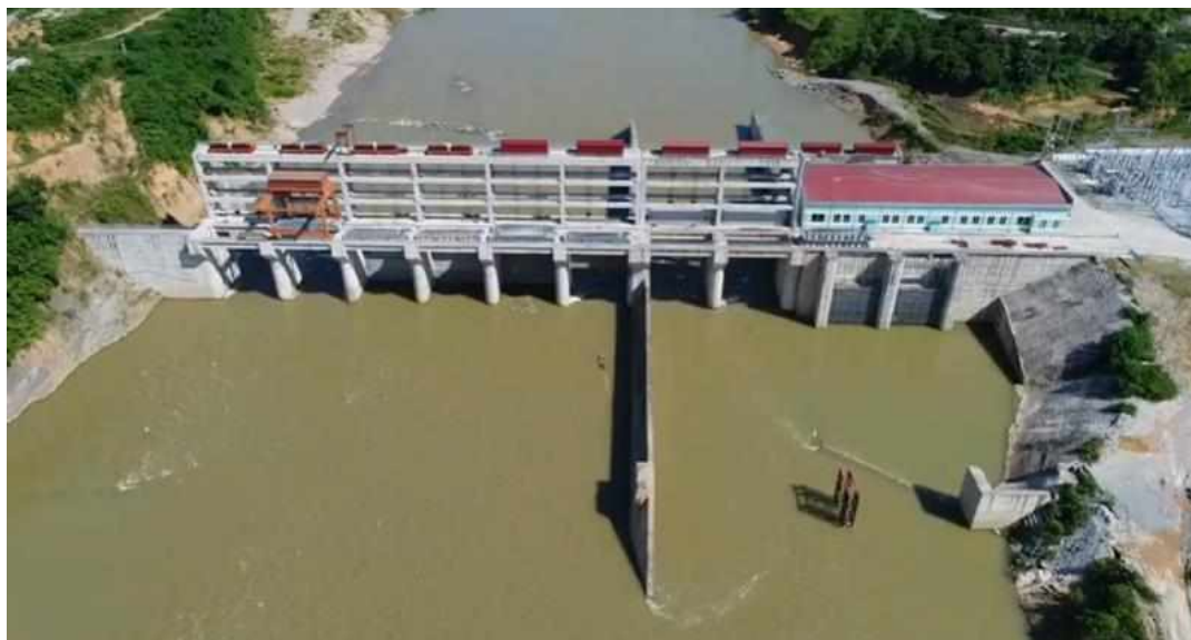
Hình 1. 4. Nhà máy thủy điện Chi Khê, Con Cuông, Nghệ An
