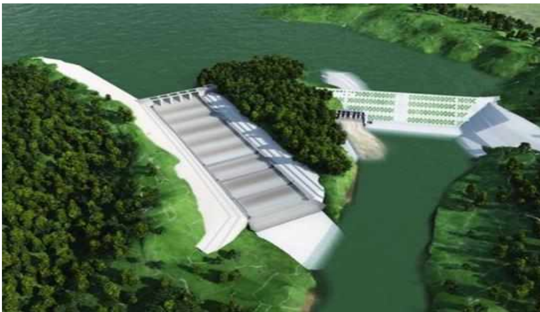
Hình 1.3. Hồ Bản Mông và nhà máy thủy điện Bản Mông
